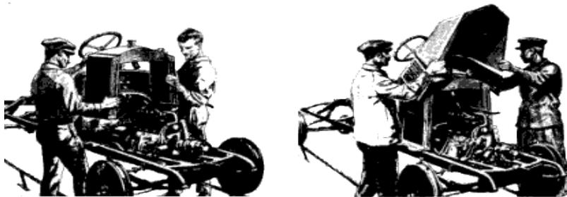
7. Le radiateur, composé de deux éléments de tubes verticaux avec collecteur central, est installé sur les longerons du châssis et fixé au tablier.
